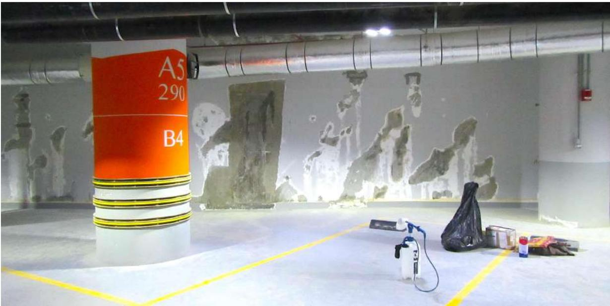
Zunächst werden Betonflächen auf Hohlräume untersucht, da durch solche Undichtigkeiten Wasser mit den darin gelösten Salzen eindringen können (Leckage).
