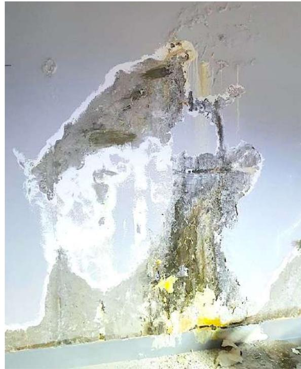
Chlorid Problem: **komsol®** empfiehlt Betonexperten hinzuzuziehen, um mit einer Zustandsanalyse zu beginnen. An verschiedenen Stellen muss der aktuelle Chloridgehalt festgestellt werden.
